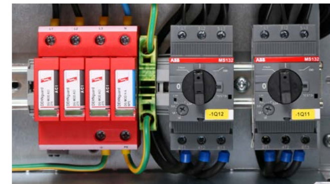
Kisfeszültségű fogyasztói rendszerek túlfeszültség-védelmére. Alkalmazható a villámvédelmi zónakoncepció szerinti LPZ 0 B – 1 vagy nagyobb határon.
